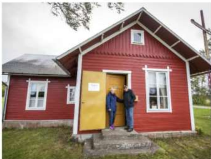
Reglementet var tydligt för alla Gotlands järnvägslinjer. Här på linjen Romakloster-Klintehamn fanns åtta stationer där husen skulle vara vinkelbyggda trähus med liggande ytterpanel nedtill och stående panel närmast taket.
